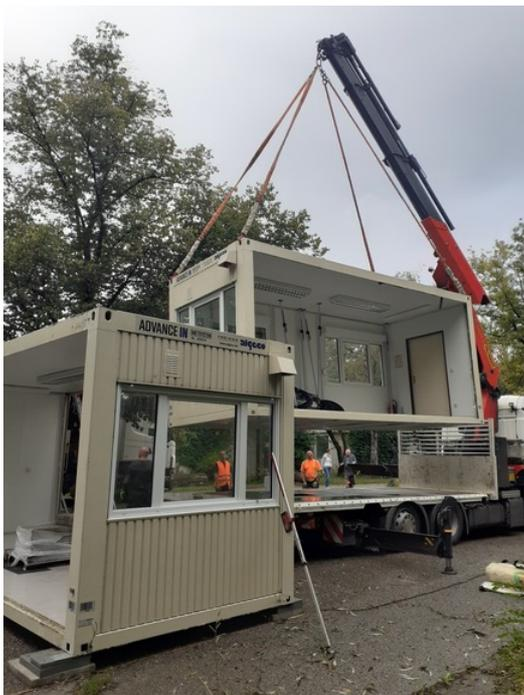
Der erste Container steht. Der zweite wird über den ersten gehoben.
